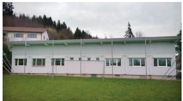
Der Schulpavillon kann energetisch nicht saniert werden - er soll mittelfristig ersetzt werden.
