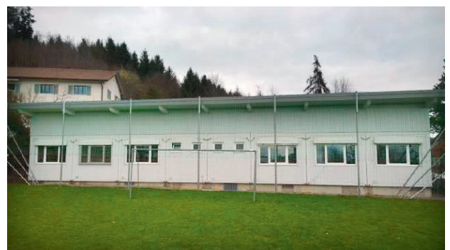
Der Schulpavillon kann energetisch nicht saniert werden - er soll mittelfristig ersetzt werden.
