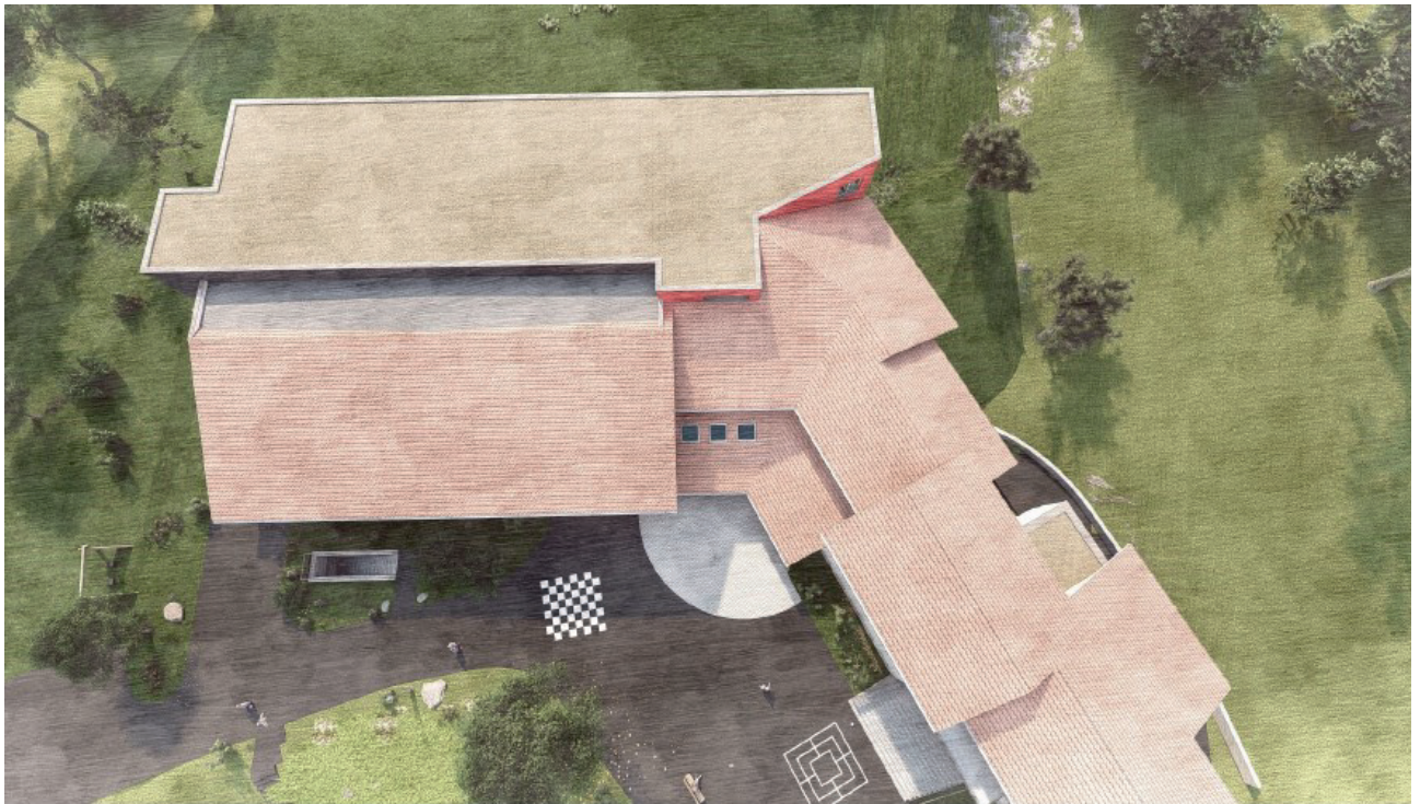
Abbildung 7: Aufgestockter Anbau, fertige Dachlandschaft und Einbettung in Gesamtgebäude.
